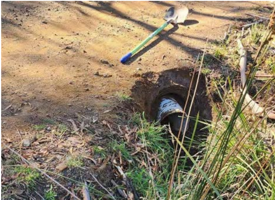
PHOTO A: 300 DIA SW PIPE INLET
